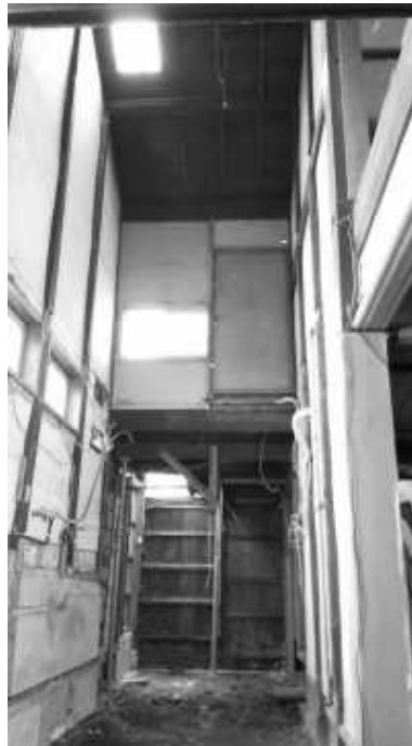
内部解体後のハシリニワ
