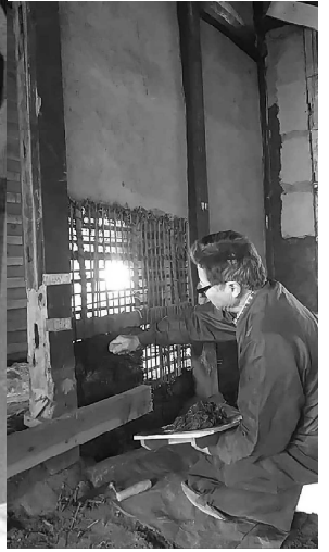
改修中の荒壁
